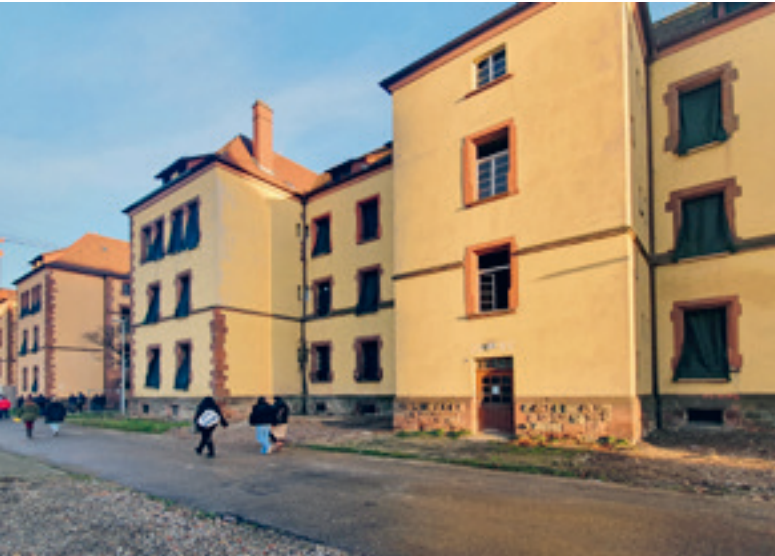
Die Sanierung hat begonnen
